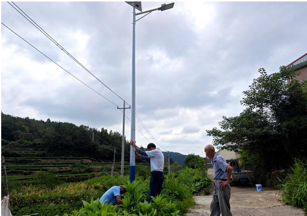
图3-26 安装太阳能路灯
